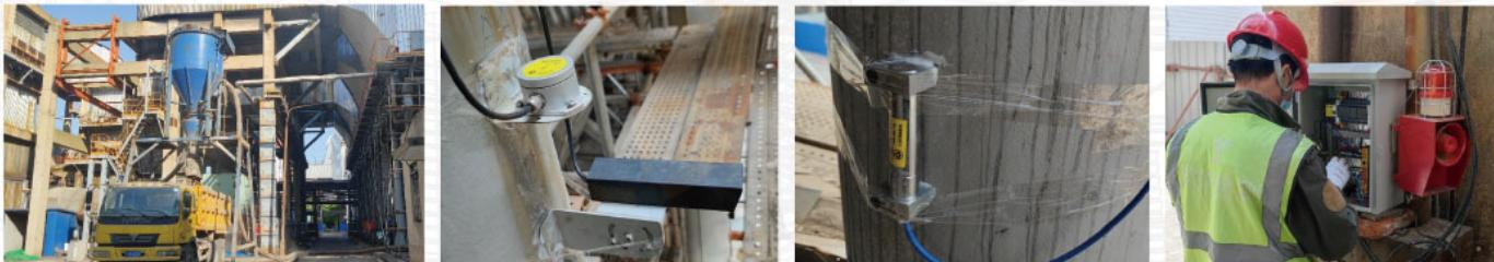
该电厂因生产需要对灰斗展开清灰作业，灰斗立柱具有高度高、荷载大、结构体系复杂、受力复杂等特点，清灰过程中受到荷载重分布的影响容易发生立柱倾斜、位移及轴力的快速变化，容易导致大规模的坍塌事故，需在施工期间对立柱的安全稳定性进行实时监测。
